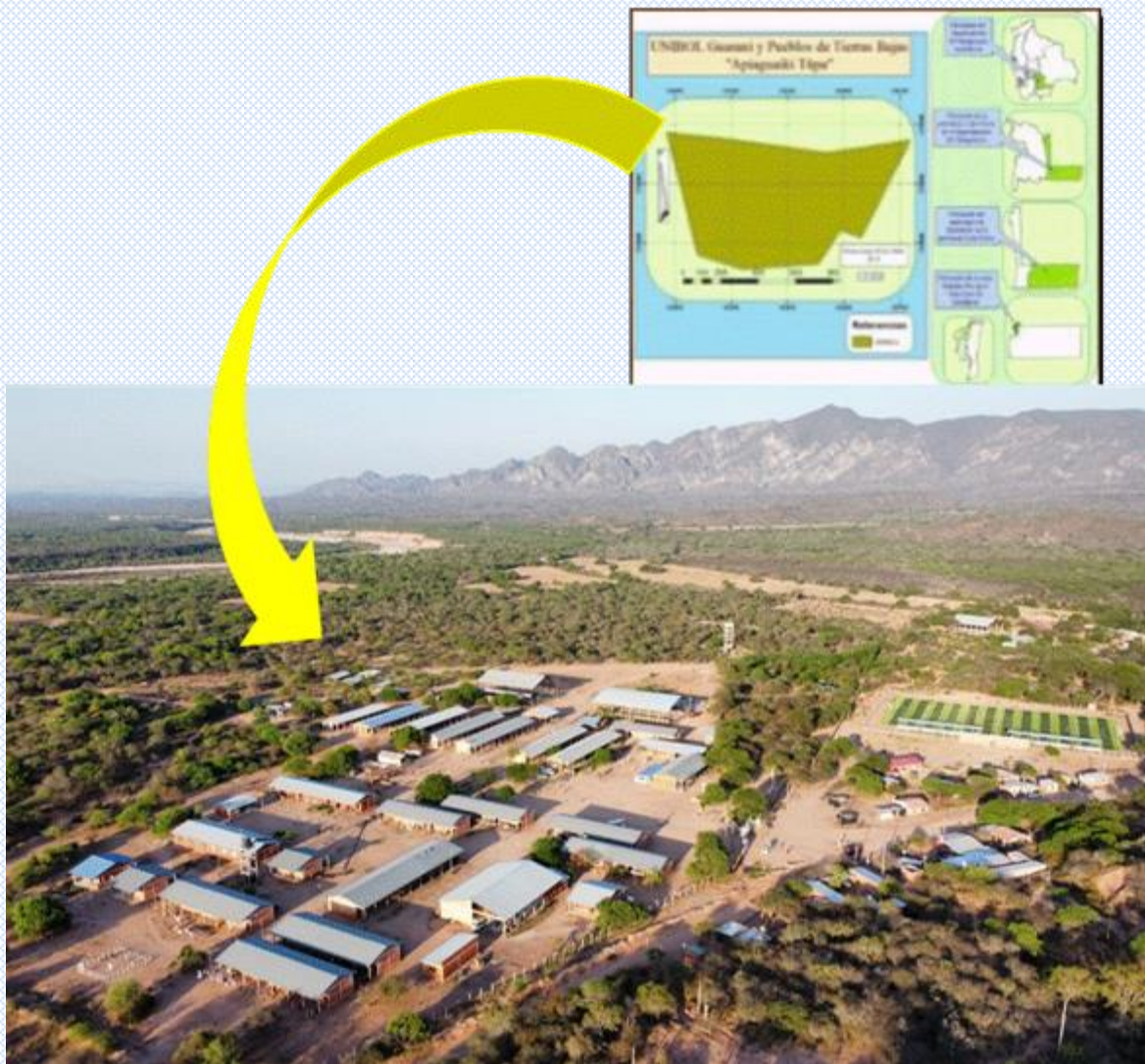
Figura 1. Ubicación y vista aérea de la infraestructura de la Unibol Guarani en Ivo
