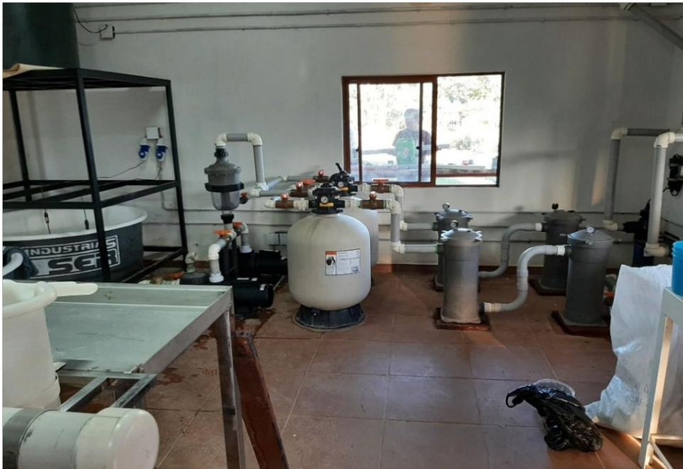
Anexo 13. Filtro MultiCyclone, de arena y cartuchos del sistema RAS.
