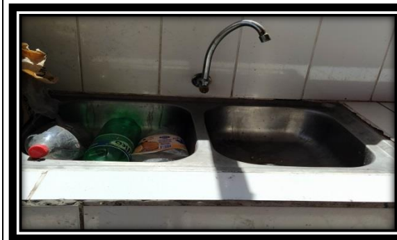
lavadero sin agua
